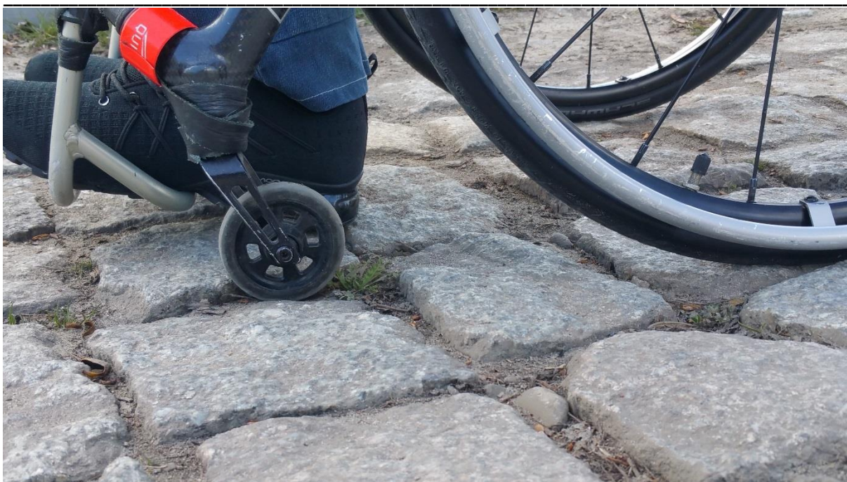
Rys. 16. Niewielkie nierówności chodnika (tu: z łupanej kostki granitowej) stanowią duży problem dla małych i wąskich kółek wózka inwalidzkiego (fot. własna)
