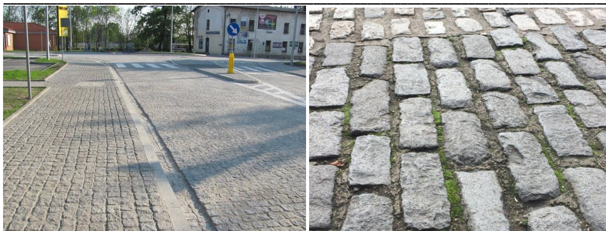
Rys. 13. Chodnik z łupanej kostki granitowej [55] i [56]
