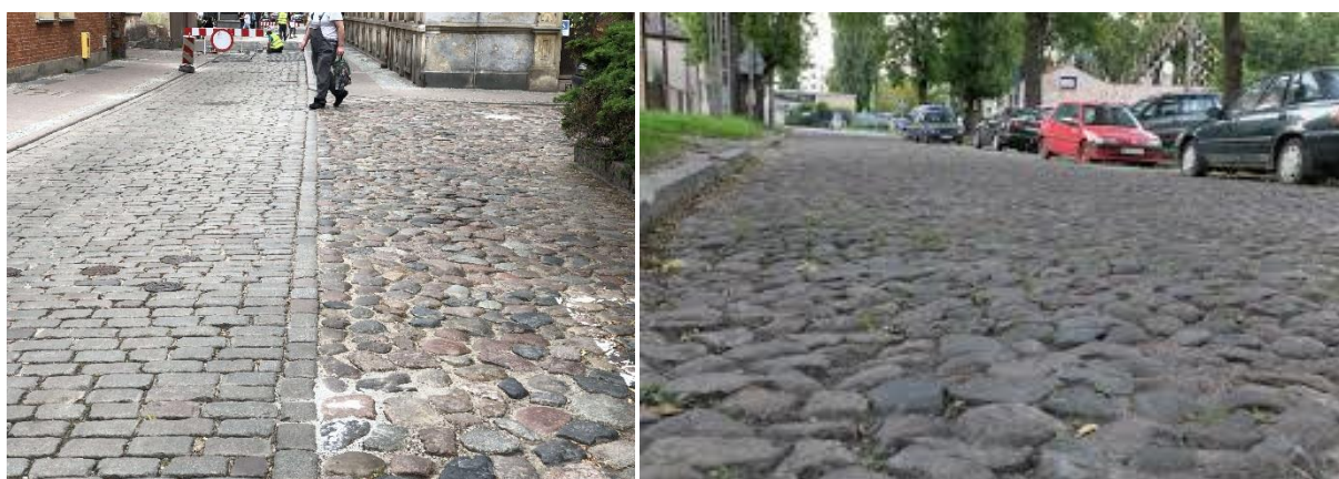
Rys. 14. Nawierzchnia brukowana z kamienia polnego [57] i [58]
