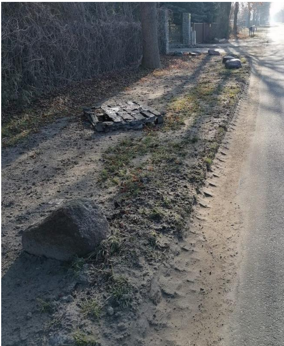
Rys. 30. Pobocze błotniste i zanieczyszczone [82]
