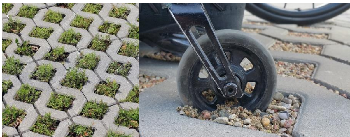
Rys. 4.6. Betonowa płyta ażurowa „Meba” [40] i problem zagłębianie się kółek przednich, występujący podczas przejazdu wózkiem inwalidzkim po nawierzchni miejsca parkingowego wykonanej z betonowych płyt ażurowych (fot. Z. Sobczyk)
