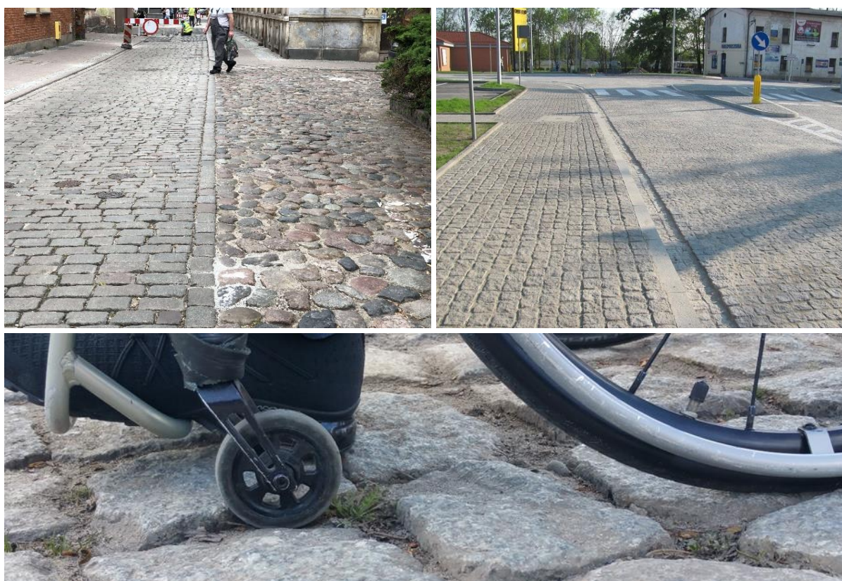
Rys. 9. Nawierzchnia brukowana z kamienia polnego [19] i kostki łupanej [20] i koło przednie wózka inwalidzkiego toczące po analogicznej nawierzchni (fot. Z. Sobczyk)
