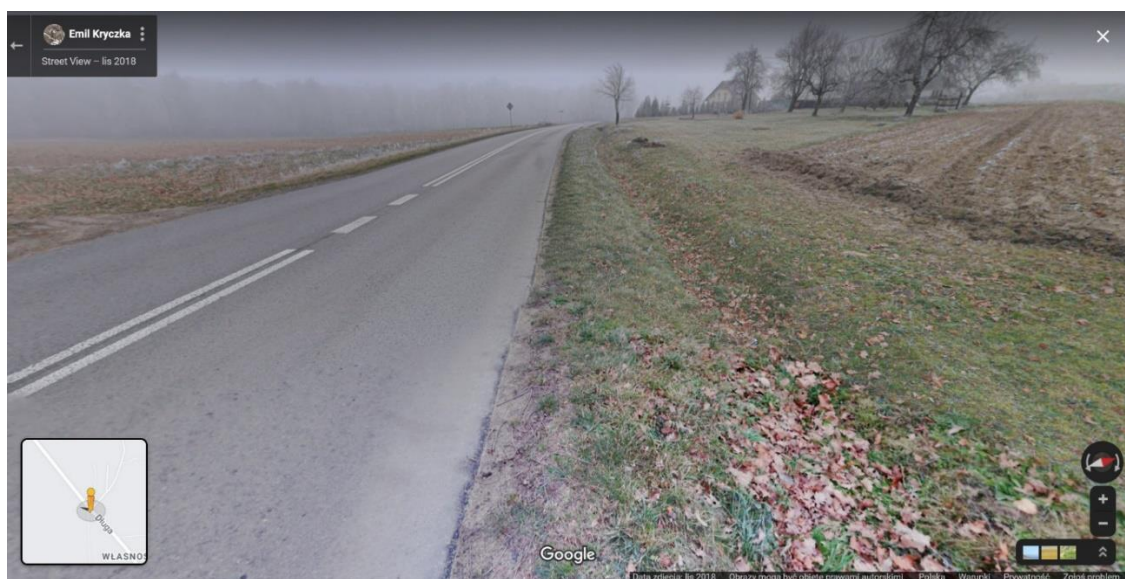
Rys. 71. „Ścieżka rowerowa” pomiędzy miejscowościami Kłoczew i Żelechów (okolice Łukowa) [fotografia z map Google]
