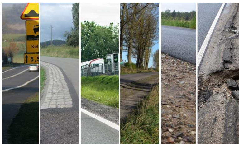
Rys. 4.7. W kolejności od lewej strony: pobocze asfaltowe [24], pobocze utwardzone kostką granitową [29], pobocze nieutwardzone [39], pobocze drogi gminnej [20], pobocze uszkodzone [30]
