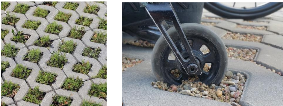
Rys. 4.6. Betonowa płyta ażurowa „Meba” [40] i problem zagłębiane się kółek przednich, występujący podczas przejazdu wózkiem inwalidzkim po nawierzchni miejsca parkingowego wykonanej z betonowych płyt ażurowych (fot. Z. Sobczyk)
