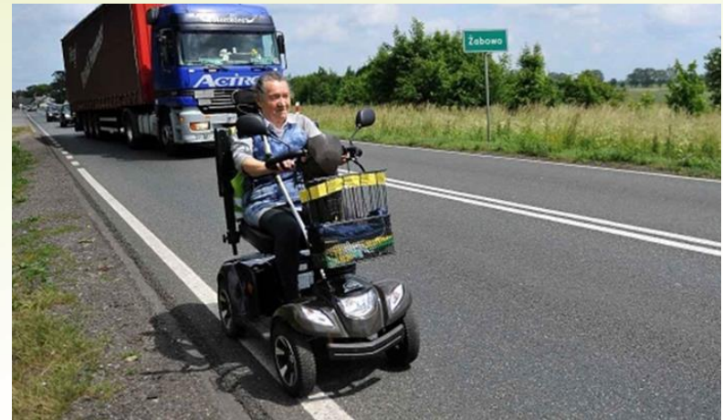
Problem z ustępowaniem wózkiem inwalidzkim miejsca nadjeżdżającemu pojazdowi przy poboczu nietwardzonym trawiasto-mieszanym
