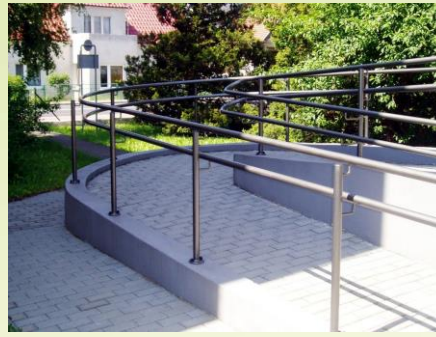
Rampa z poręczami
